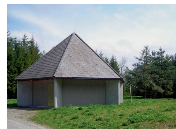
Die Trinkwasserversorgung aus dem Aaretal hat hohe Priorität.
